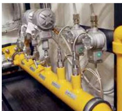
Trasmettitori di pressione e temperatura, termostati e pressostati per controlli multipli PT, TT, PS and pressostats for multiple controls
