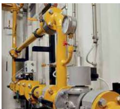
Linea di misura Metering system
