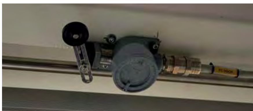
Sistema automatico di accensione luci interne all'apertura della porta ingresso Automatic system for turning on internal lighting when the entrance door is opened
